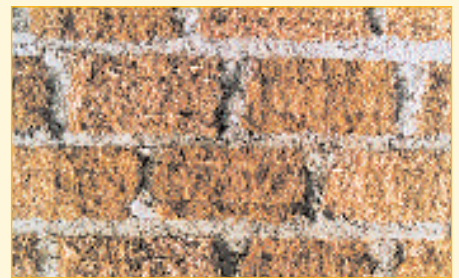
Les "bottes de paille crépies" pour les murs de l'élevage des jeunes et de la grange. (photo prise avant de crépir).
