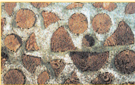
Le "bois cordé" pour la salle de vente, la salle de traite, la chèvrerie.
