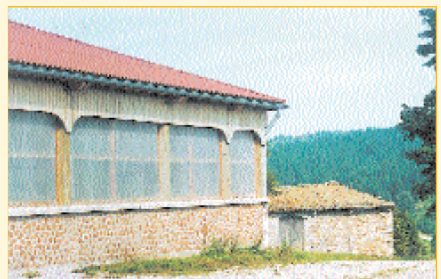
Le bois cordé s'harmonise avec les murs de pierre voisins. La forme de la voûte de la porte de grange traditionnelle est reprise dans le bardage bois de la façade sud de la chèvrerie.
