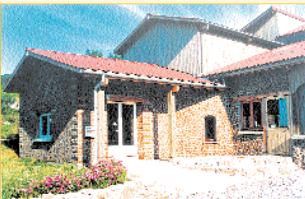
Espace d'accueil du public : parking, entrée fromagerie et salle de traite. Le bois cordé se marie aux dalles de granit.
