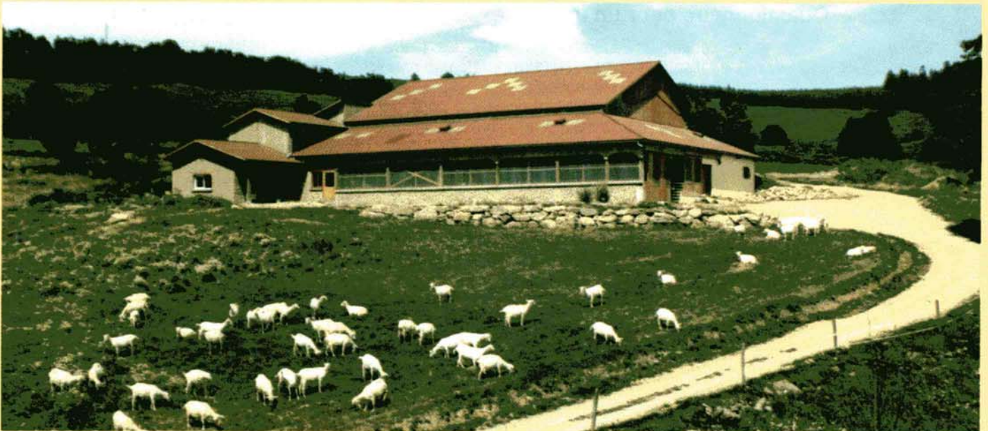
Le bois cordé des murs de la chèvrerie s'harmonise avec les murs de pierre voisins.
