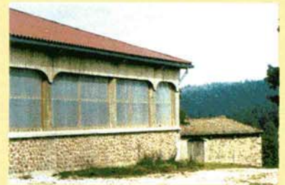
La forme de la voûte de la porte de grange traditionnelle (au fond) est reprise dans le bardage bois de la façade sud de la chèvrerie.
