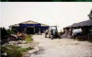
Cour en mauvais état
