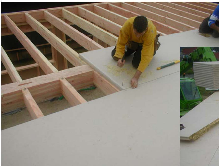
Pose en plancher sur solivage bois
