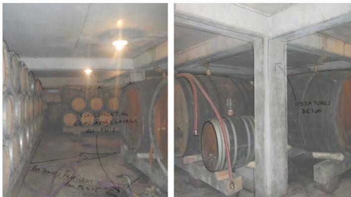
idem, un grand espace libre rectangulaire (miroir du chai), pour pouvoir agencer librement les tonneaux si besoin. Sol bétonné car besoin de drainer et garder le sol propre après le nettoyage des tonneaux.
