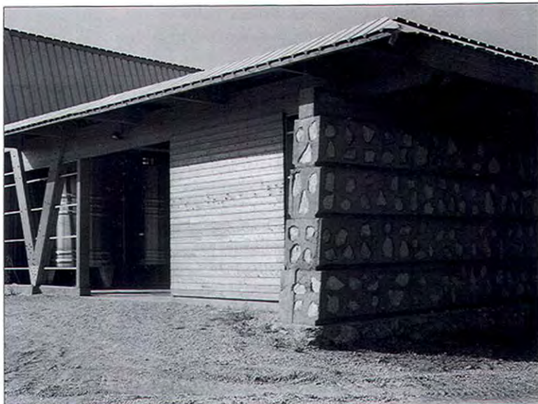
Le mur de béton cyclopéen se poursuit sur les 30 m de long de la façade
