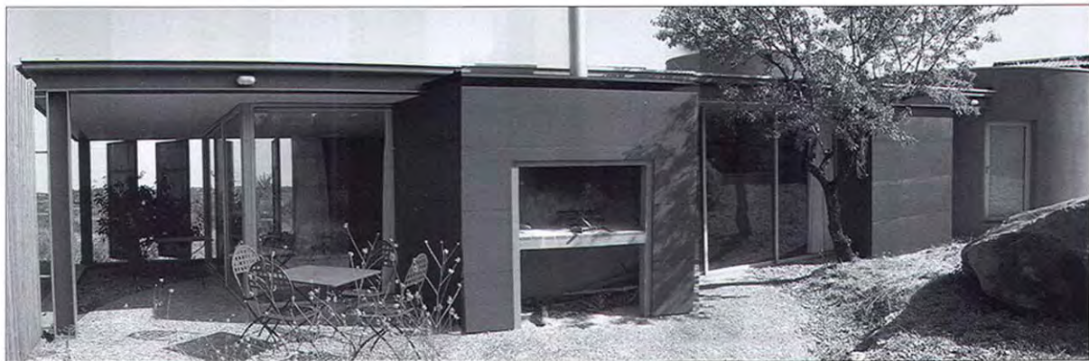
Un espace intime est créé sur l'arrière de la maison, il conserve une vue sur le paysage grâce à de généreuses ouvertures. Des persiennes orientables en bois occupent trois côtés de la pièce principale. Ces volets pivotent sur un axe vertical offrant à la fois la possibilité de jouer avec la lumière comme celle de cadrer des vues en fonction de l'humeur, du temps, ou du vin à déguster...
