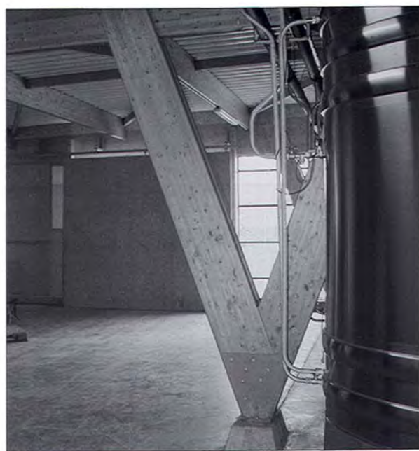
Les poutrelles de bois en lamellé collé supportent le bardage de la toiture, tout en dégageant l'espace au sol
