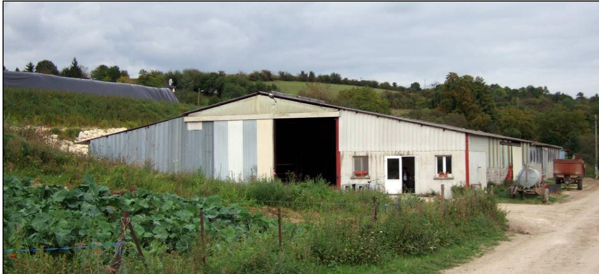
Figure 6 : Exemple d'un bâtiment moderne, probablement fait soi-même... (source personnelle)
