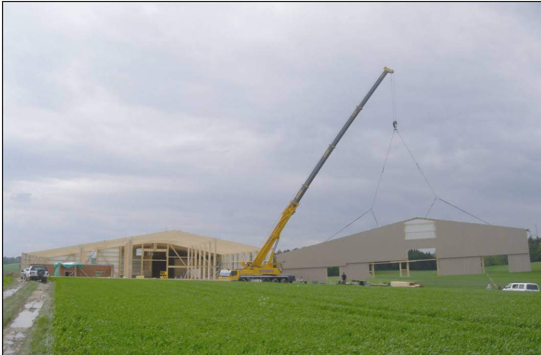
Figure 20 : Phase du levage d'un pignon (source Farmwood)
